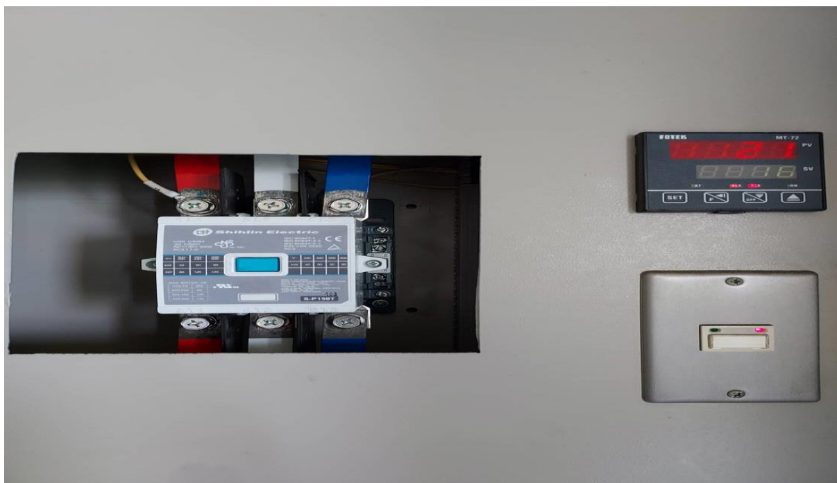
照片說明：冷氣設置溫控開關
