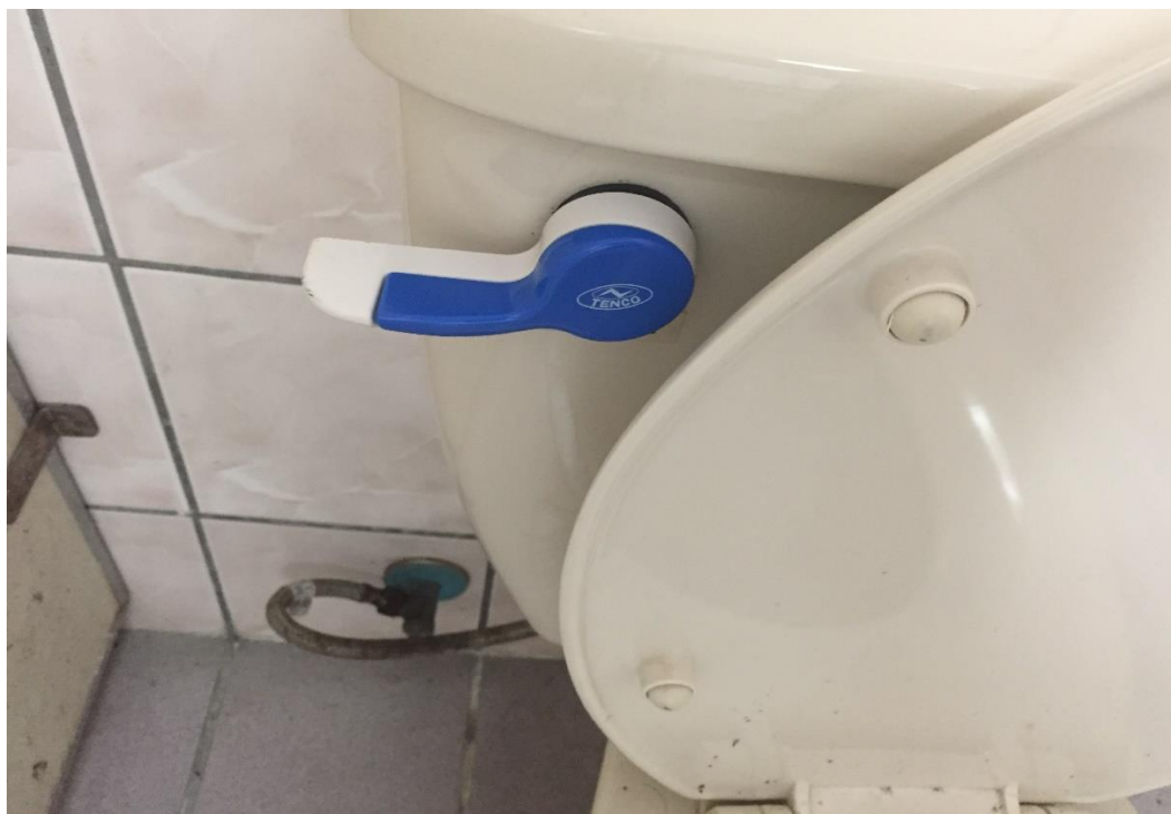
照片說明：節約用水二段式沖水
