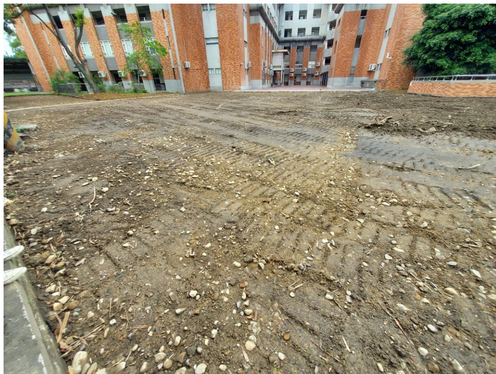
照片說明：停車場整地工程
