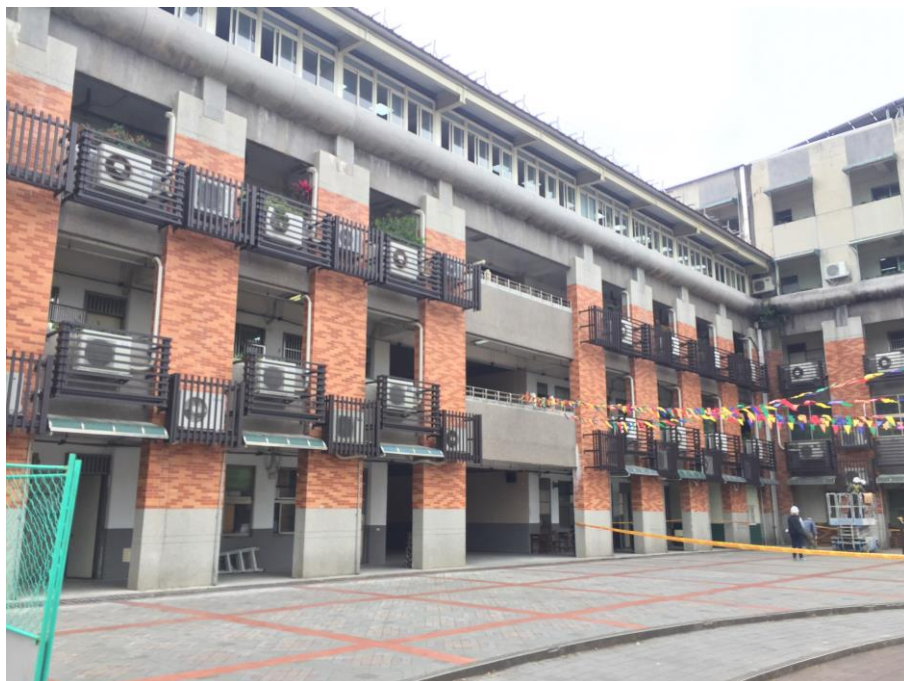
照片說明：教學大樓外隔柵工程
