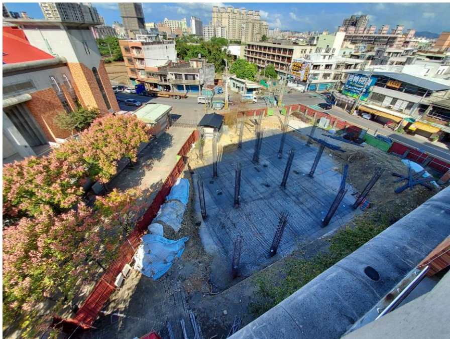
照片說明： 幼兒園興建工程
